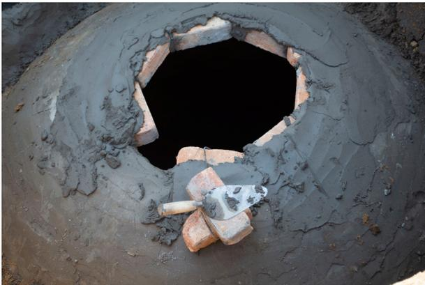
Die dritte, rechteckige Filtrationskammer wurde mit größeren Zementblöcken hinter der zweiten Kammer platziert und mit dieser verbunden. Zuletzt wurden alle Kammern von innen sowie außen mit feinerem Mörtel abgedichtet und mithilfe von Betondeckeln verschlossen.
